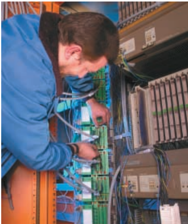
Die Arbeiten wurden parallel zum laufenden Betrieb durchgeführt.
